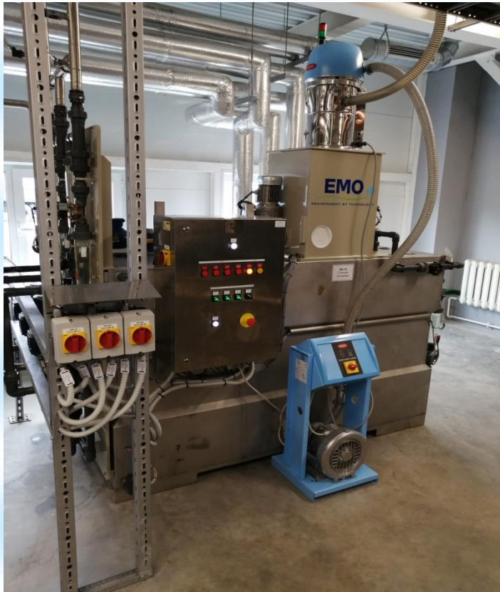
станция дозирования полимера
