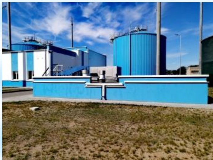
насосная станция перекачки сброженного осадка, резервуар ОМИ
