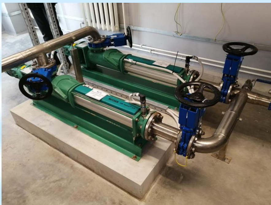
винтовые насосы уплотненного ила
