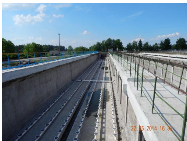
аэротенк первой очереди после проведенных работ в рамках проекта PRESTO
