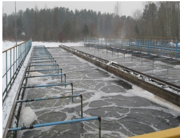
контактные резервуары
