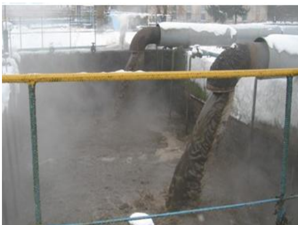
резервуар обратного ила
