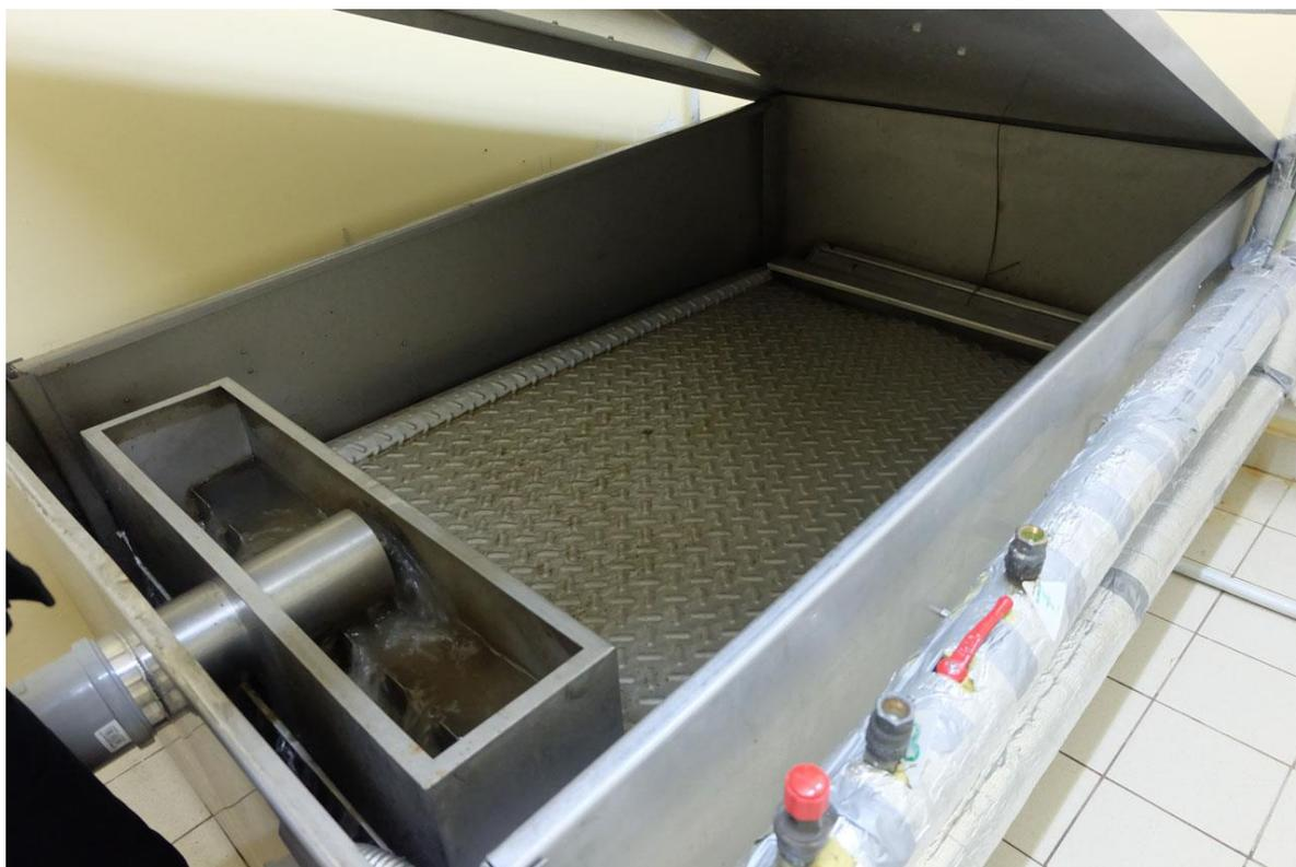
Применение альтернативного источника энергии на основе геотермального теплового насоса номинальной тепловой мощностью 12 кВт с использованием температуры сточных вод позволило полностью отказаться от строительства теплотрассы и за счет исключения тепловых потерь при транспортировке теплоносителя ежегодно экономить более 80 Гкал тепловой энергии, что эквивалентно 11 600 кубометрам газа в год. Экономический эффект составит более 7 600 рублей в год.
